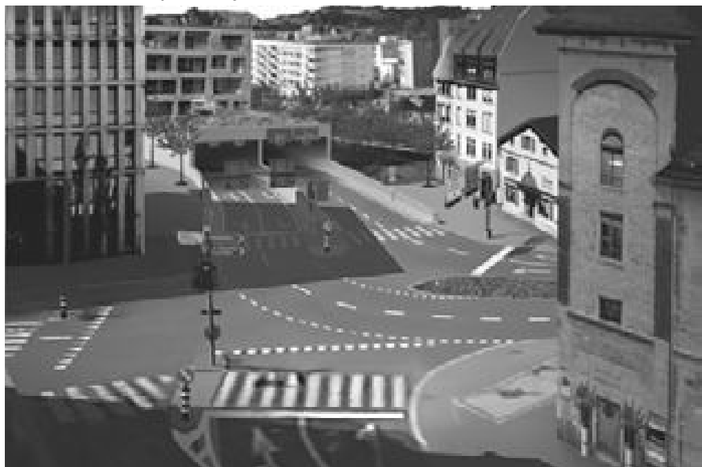
Anschluss Güterbahnhof, Kreuzung Geltenwilenstrasse.
